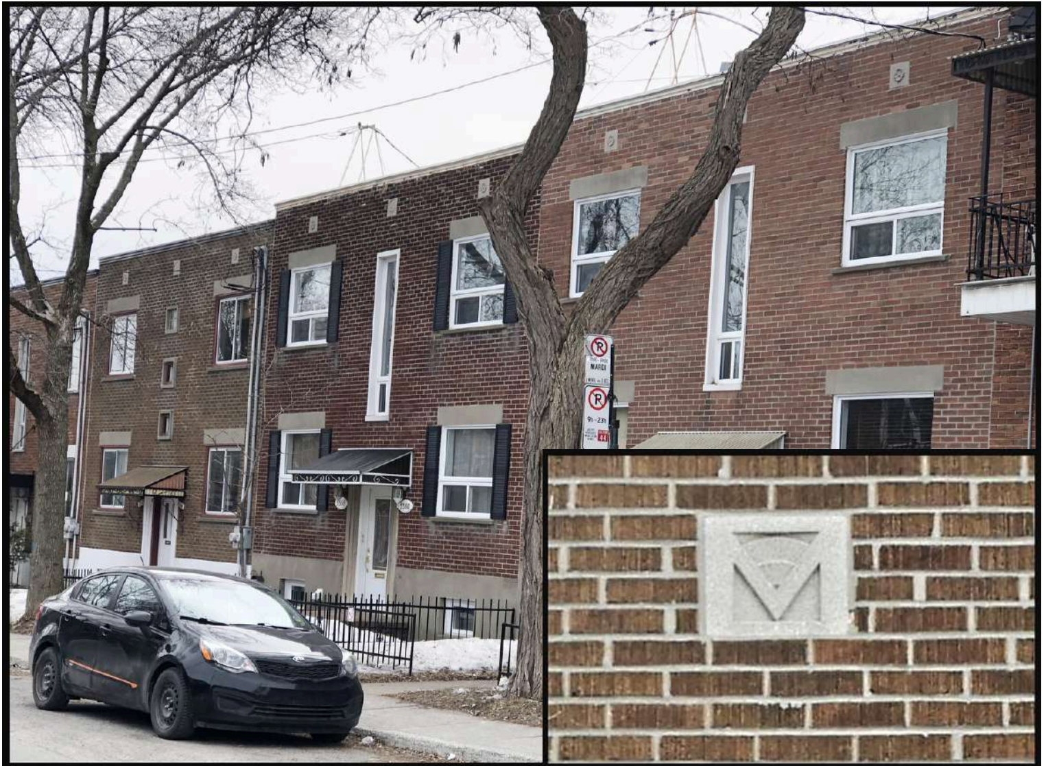
Figure 15.5 Les duplex construits par les Miron, rue Saint-André, côté ouest et la signature des frères Miron; photographie de Normand Guilbault.
