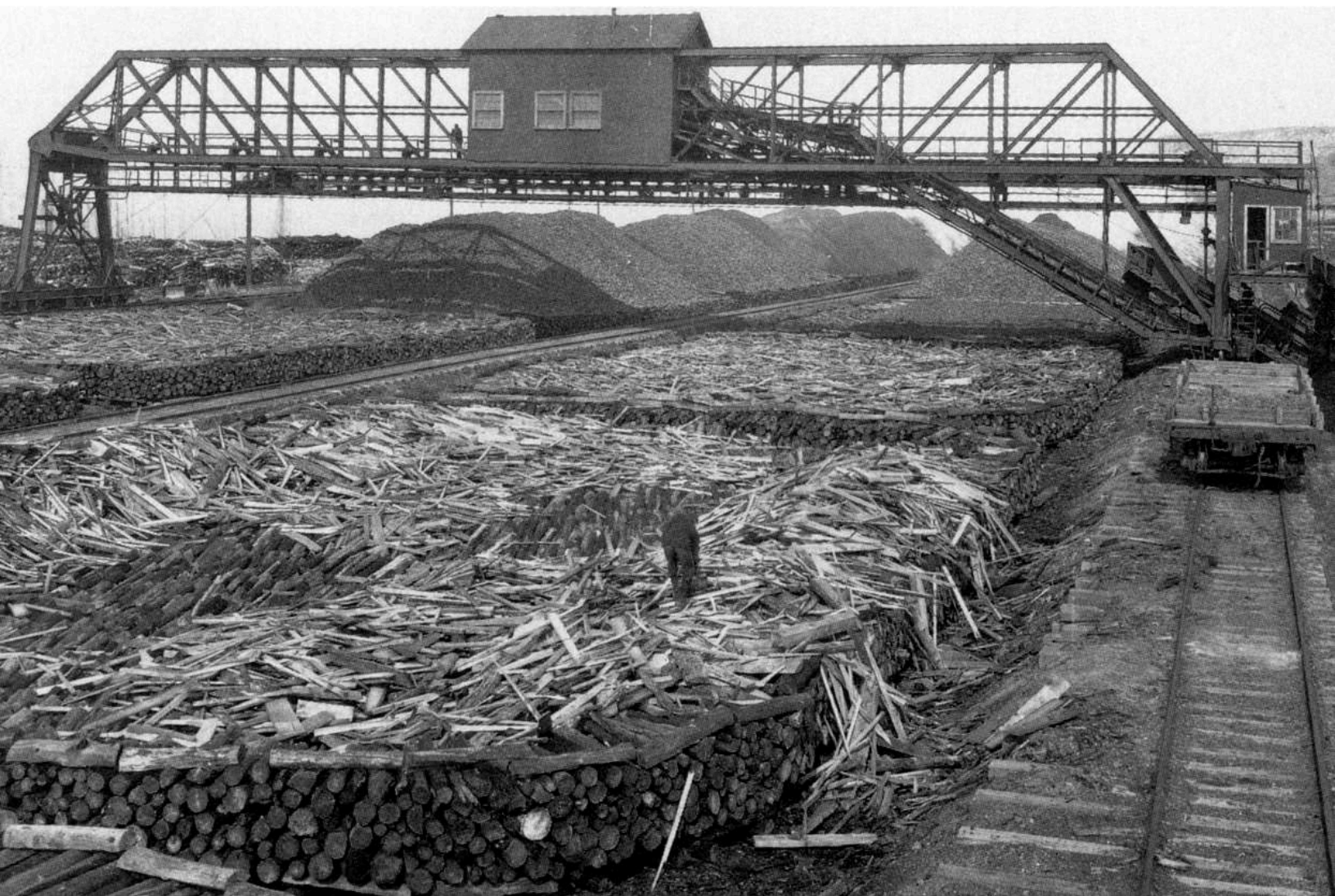
Figure 3.1 Le champ de frittage O'Donnell près de Sudbury en train d'être chargé de milliers de tonnes de roches sulfureuses sur un lit de bois de chauffage de 4 pieds de hauteur; INCO, [1916].
