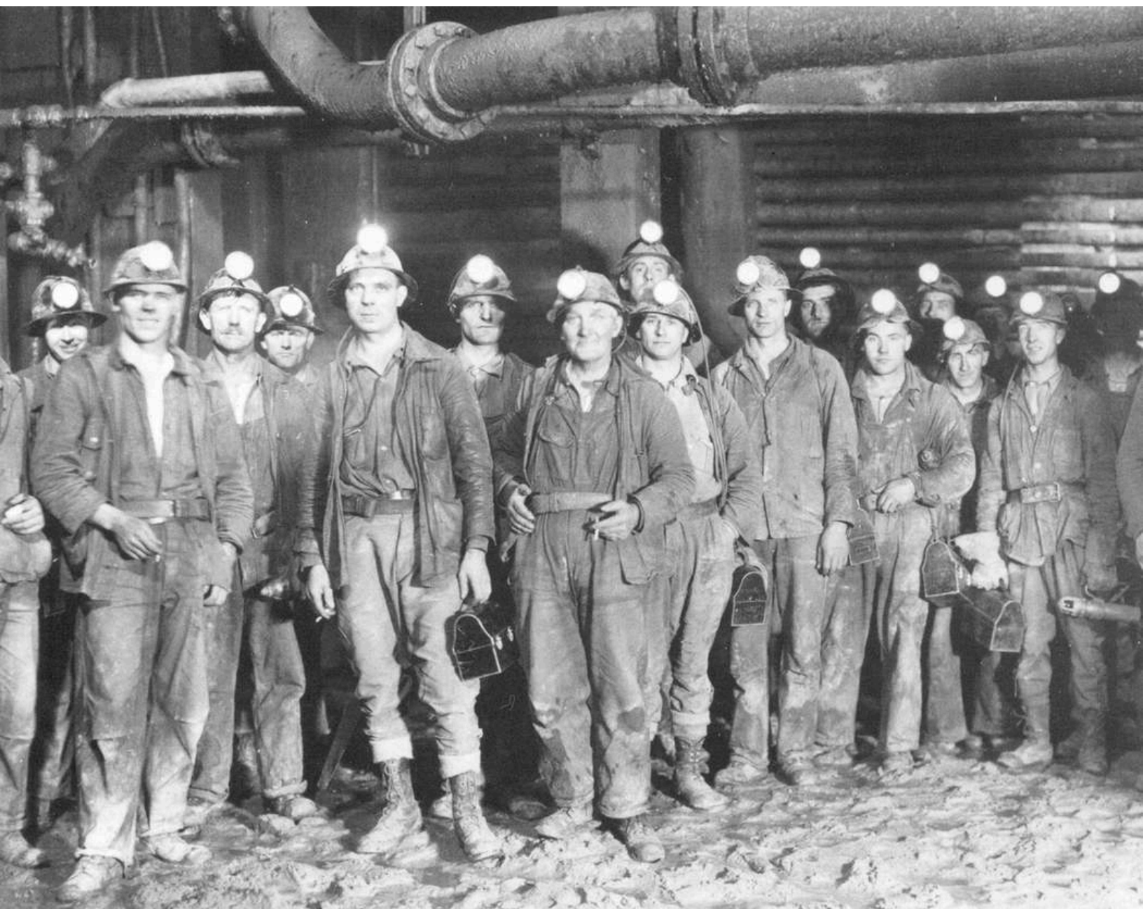
Figure 4.4 C'est à compter de 1934 que les travailleurs du fond sont équipés de lampe électrique accrochée sur leurs casques. Des travailleurs de la mine Hollinger attendent la cage de l'ascenseur vers 1936. C'est peut-être dans une telle situation que certains ont discuté de la grève; BAC, PA 17570.
