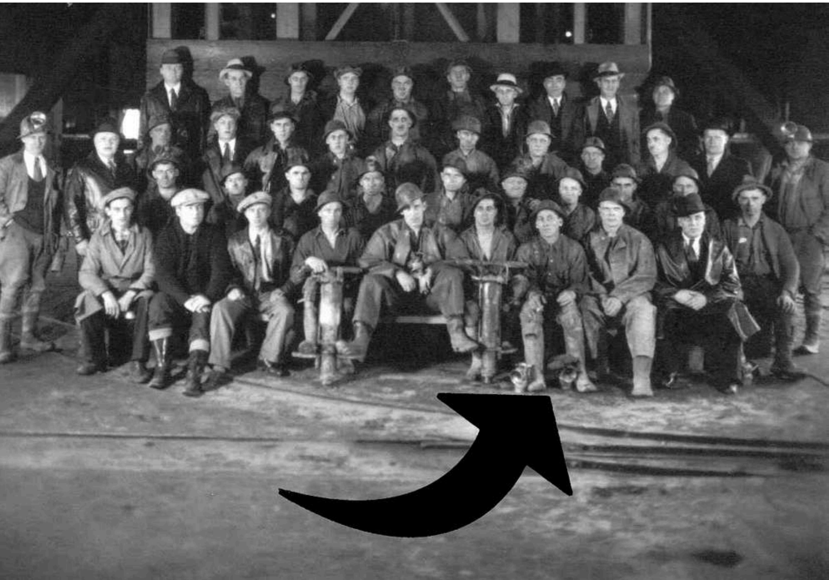
Figure 6.11 Les creuseurs de puits de la mine Wright-Hargreaves à l'été 1936; certains portent des lampes électriques sur leur casque, d'autres ont déposé à leur pied des lampes au carbure (la flèche noire); Museum of Northern History.
