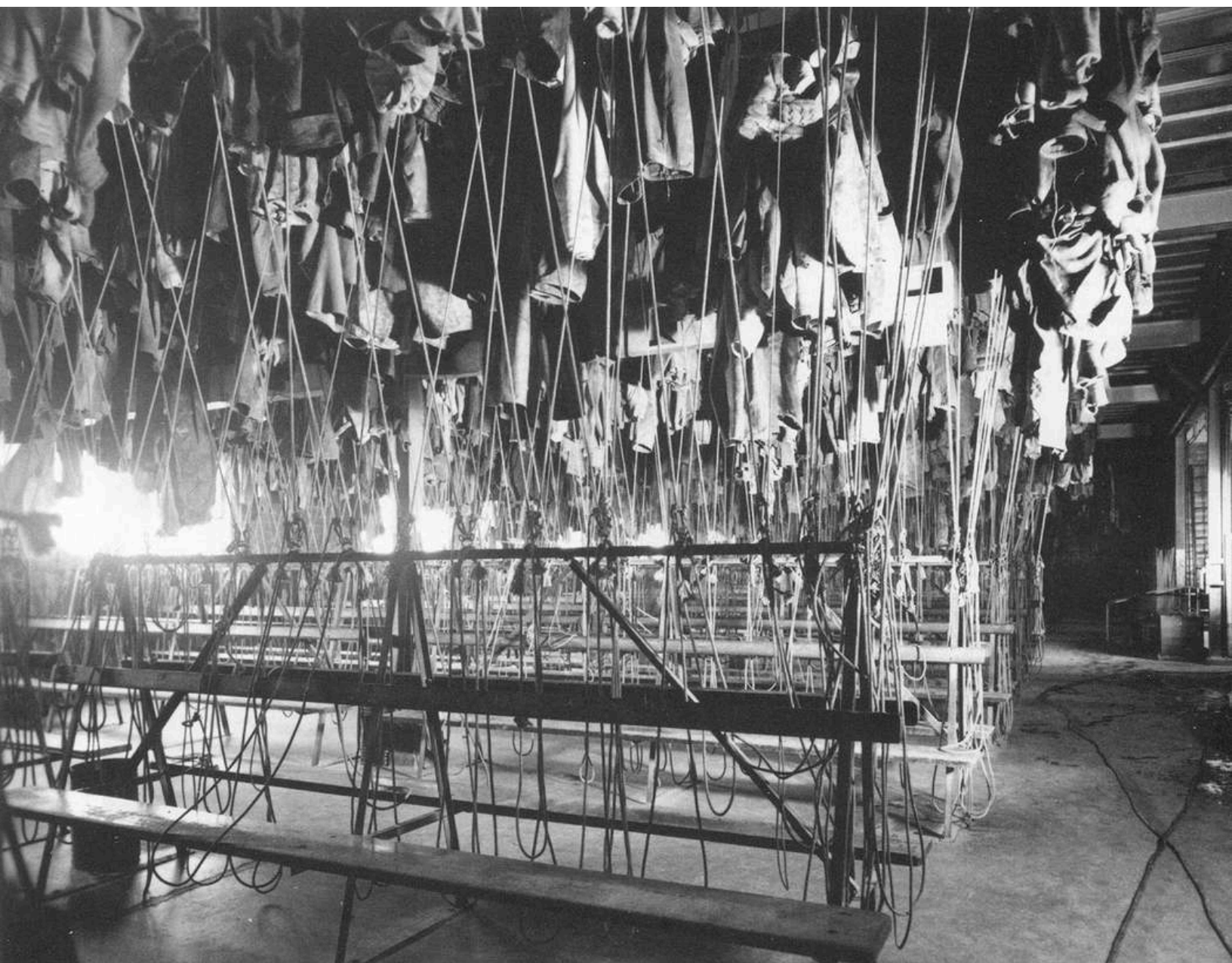
Figure 4.5 Le vestiaire-séchoir de la mine McIntyre de Timmins en 1936. Un décor typique de toutes les mines du Nord. Chaque ouvrier-mineur a une place assignée pour changer de vêtement qu'il hisse ensuite à l'aide d'une corde; BAC, PA 17581.
