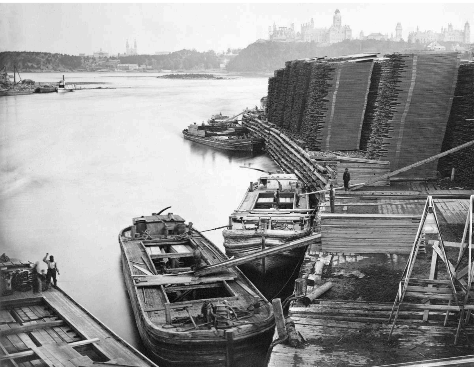
Figure 1.4 Des barges servent à transporter des madriers et des planches dans la région d'Ottawa; musée MCord, 1872, William Notman & Son, no d'accession 1-78911.01.
