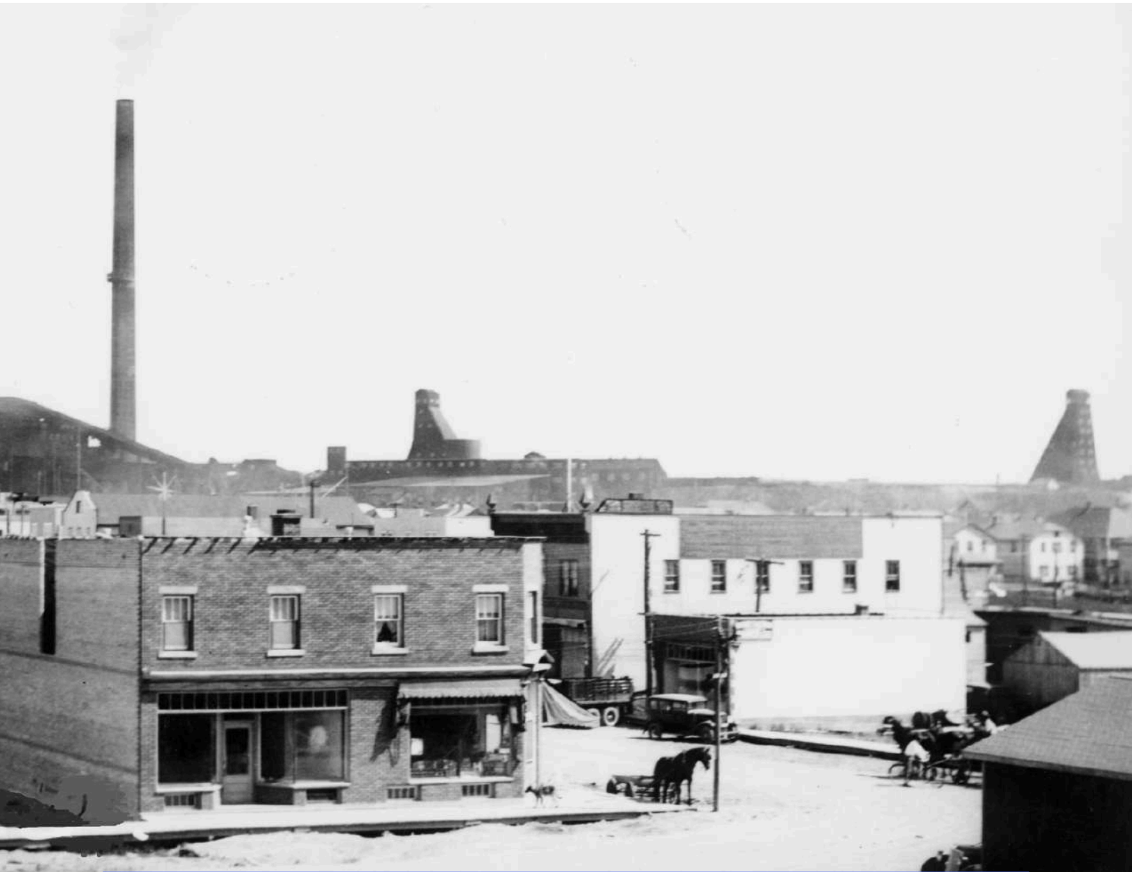
Figure 4.2 Une des cheminées de la fonderie avec à sa droite deux chevalements de la mine Horne qui signalent la présence de puits de mine; Archives nationales du Québec en Abitibi-Témiscamingue, fonds Vavasour & Dick, circa 1930, 08-Y, P123-1/285.
